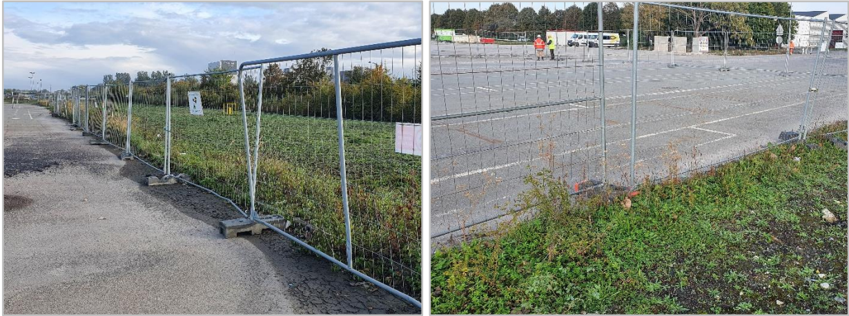
Photos 3 et 4 : Zone d'évitement correctement balisée mais facilement pénétrable (Rainette, 2022)
