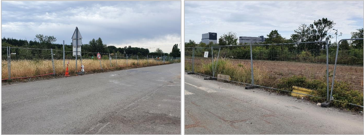
Photos 3 et 4 : Zone d'évitement correctement balisée (à gauche) et exemple d'ajouts nécessaires de brides aux clôtures de chantier (à droite) (Rainette, 2022)
