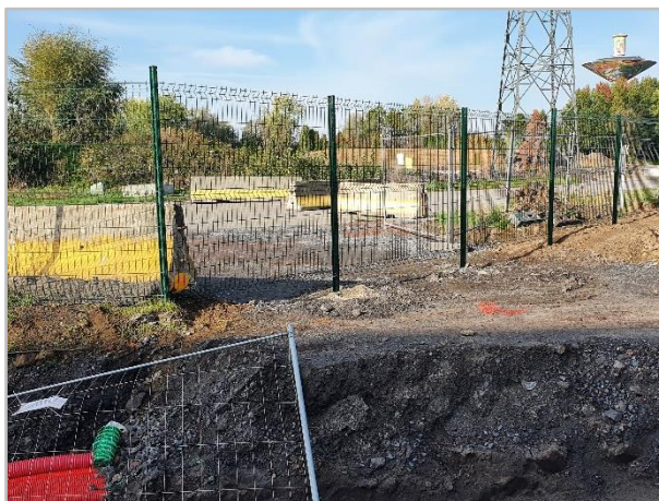
Photos 16 : Accès refermé avec pose d'une clôture pérenne (Rainette, 2022)
