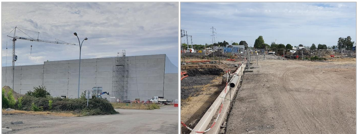
Photos 1 et 2 : zones en chantier pour la construction (Rainette, 2022)
