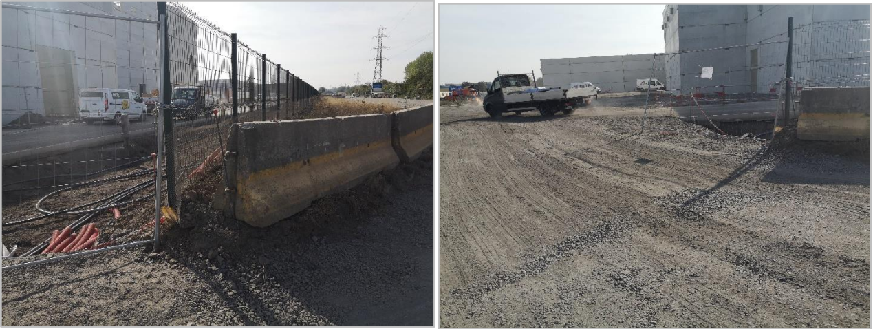
Photos 4 et 5 : Ouverture à l'extrémité nord de la barrière donnant sur le passage des engins de chantiers (Rainette, 2022)
