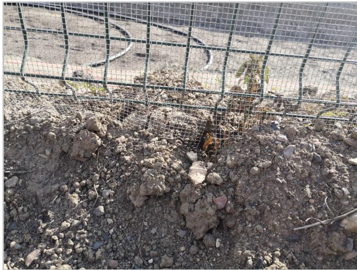
Photo 1 : Petite ouverture au nord de la barrière à amphibiens (Rainette, 2022).
